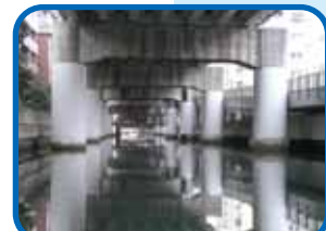
高架に覆われた閉鎖的な河川空間
