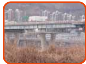
橋の下の展望スペース（韓国・ソウル）
