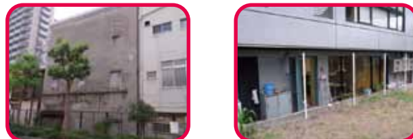
昔ながらの出入口が残る蔵 川側に出入口を設けた建物
